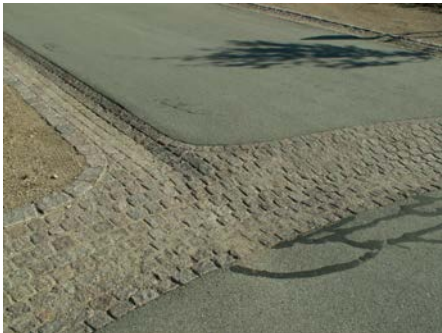
Eksempel på vandrende langs boligvej
