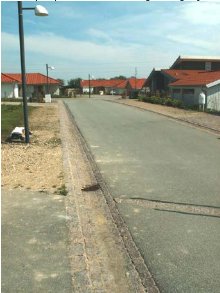
Eksempel på vandrende langs boligvej
