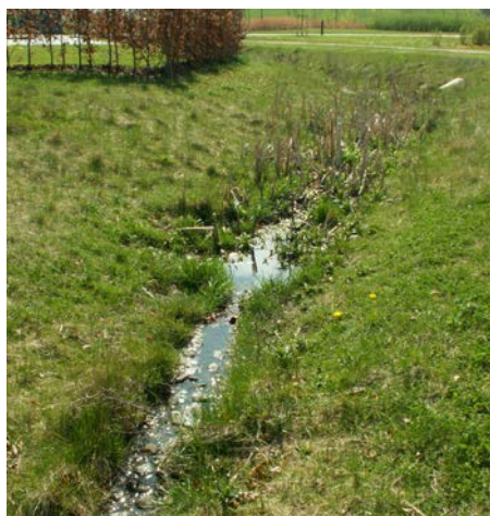
Eksempel på grøfter til regnvandshåndtering
